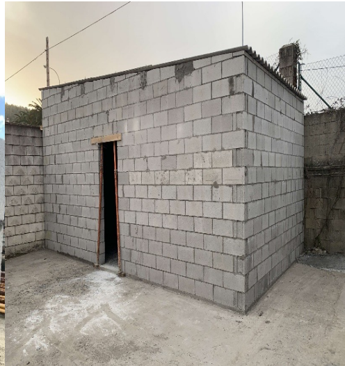
Constructive module: 4m x 3m x 3m
